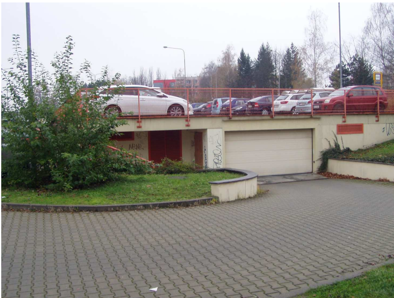
Obrázek 31: Dvoupodlažní polozapuštěná garáž s celkovou kapacitou 50 stání, Ostrava
